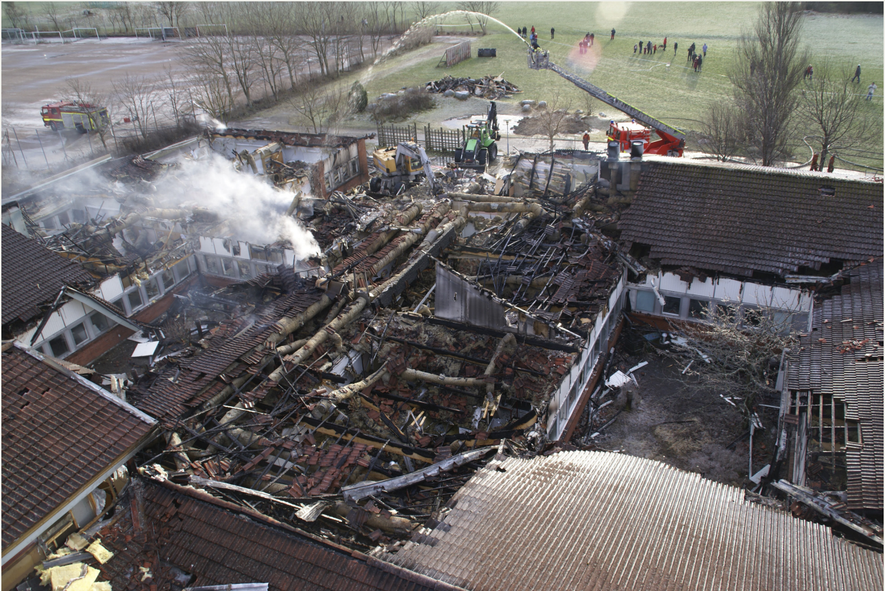
Bild 2: Omfattande brand till följd av en anlagd brand (Foto: Stefan Svensson).
